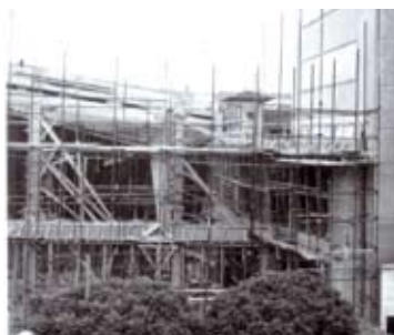
> cantiere per la costruzione della chiesa
