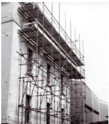
> lavori in canonica
